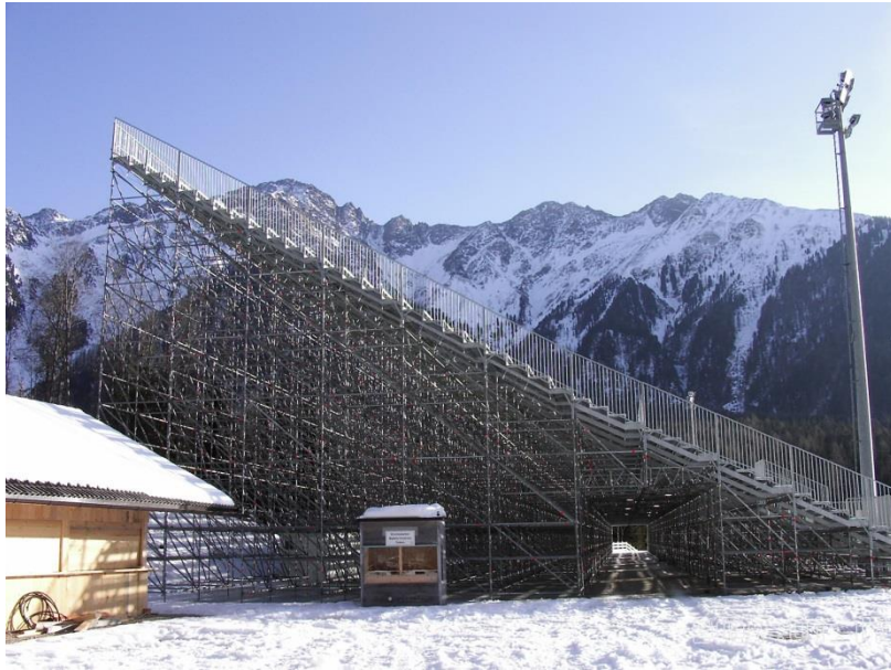
Példa egy lelátó kialakítására Layher elemekből
